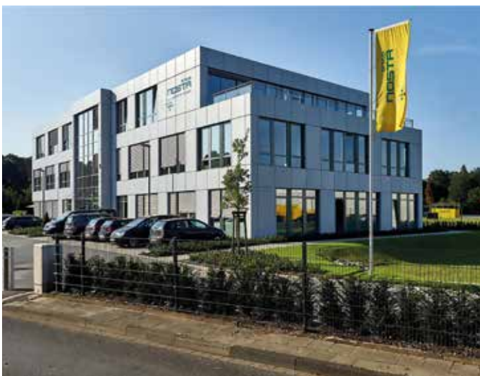
NOSTA Standort Ladbergen.
