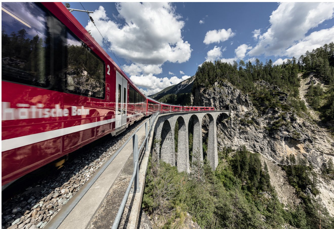
Interregio of the Rhätische Bahn on the Landwasser Viaduct.
