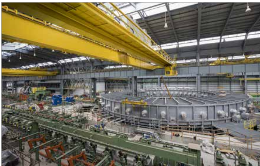
Строительство кольцевой печи на заводе TenarisBayCity.
