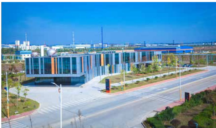
Завод VAMA в Лоуди, провинция Хунань, Китай.
